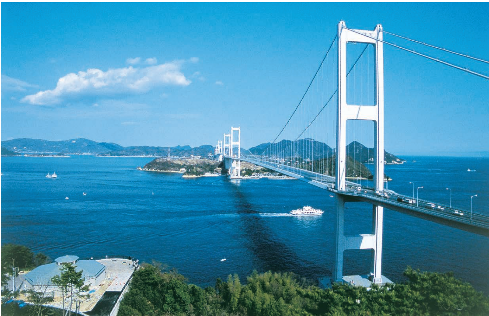
来島海峡大橋／全景
