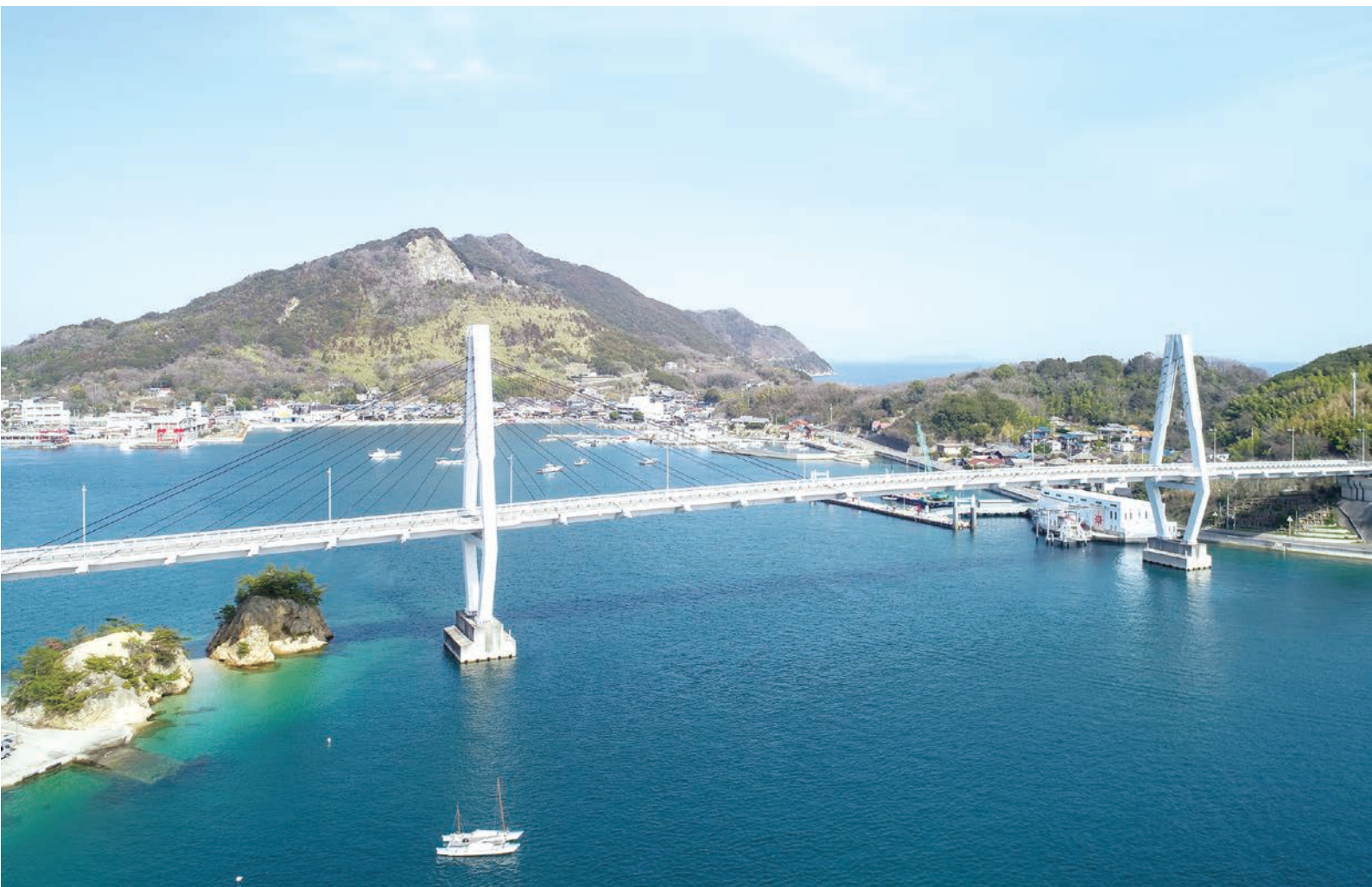
越智郡上島町「弓削大橋」
