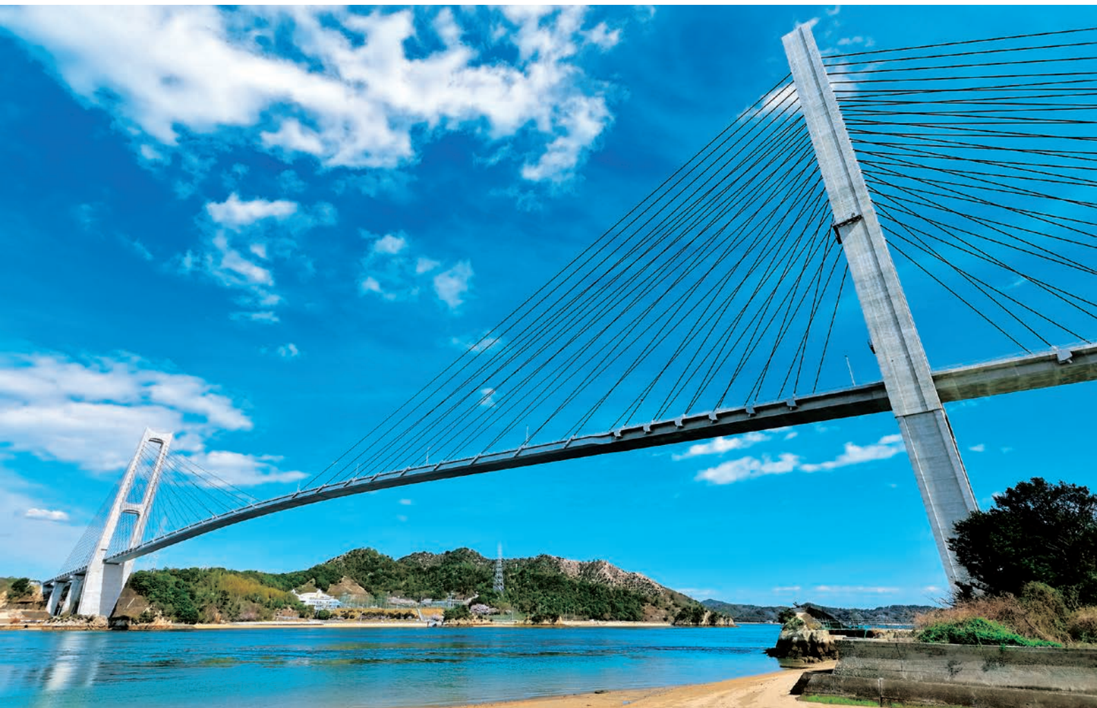
越智郡上島町「岩城橋」
