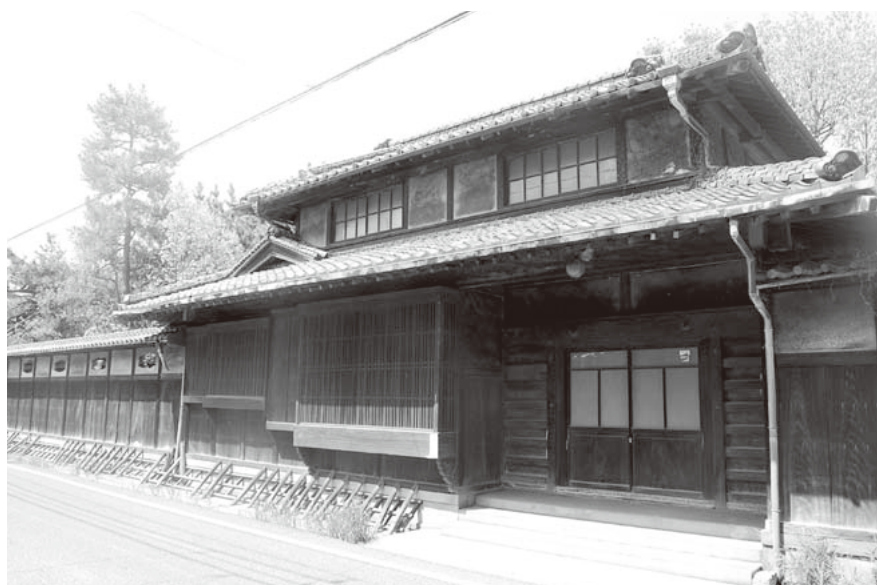
八木亀三郎家旧宅（波止浜地区本町通り）
