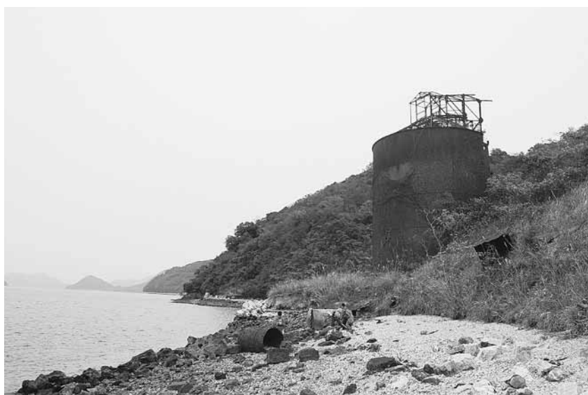
島に残る唯一の石灰貯蔵タンク
