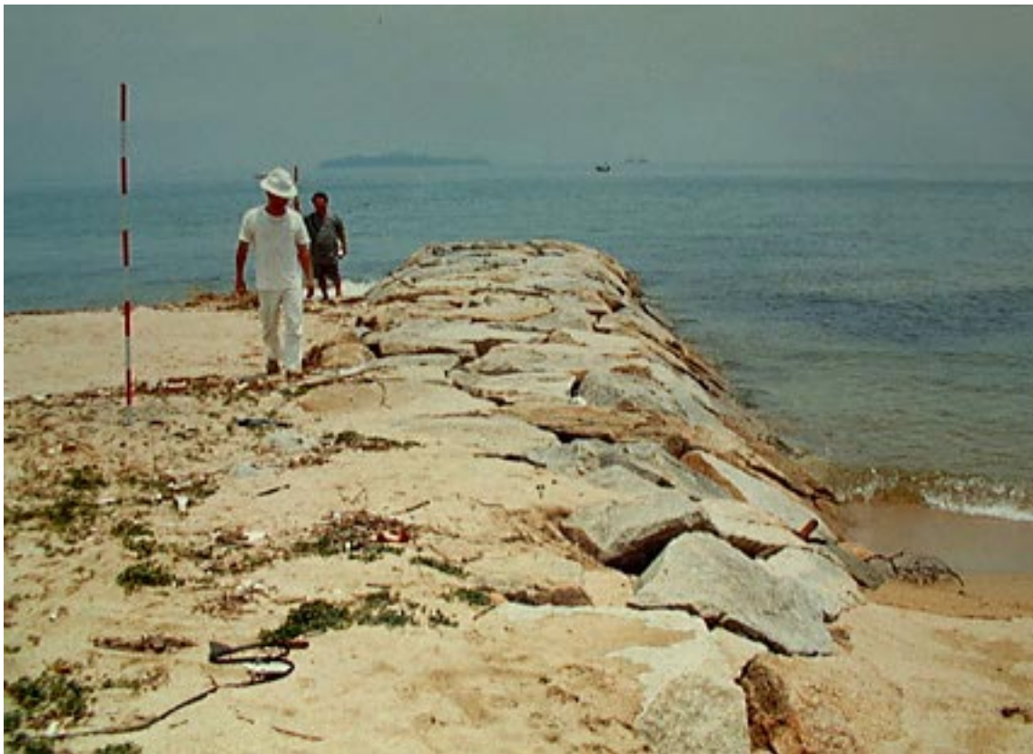
屯田川の左岸堤防を調査する会員（1985）
