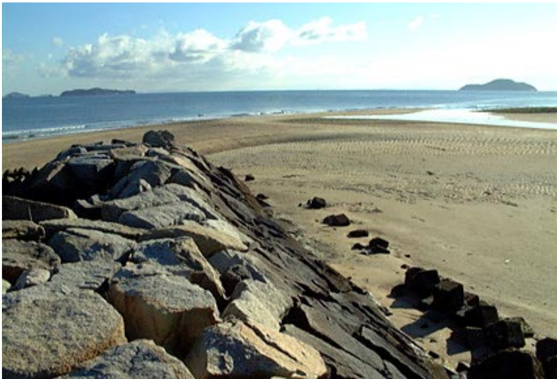
現在の屯田川の左岸堤防（1999）基部まで完全に 露出して孤立している
