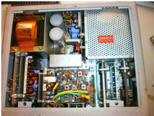
上蓋を外した景色 (掃除後)
